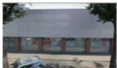
Edificio EX Esvelunga – Lato viale Giannotti
