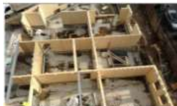
Porzione di edificio con pareti XLAAl montate
